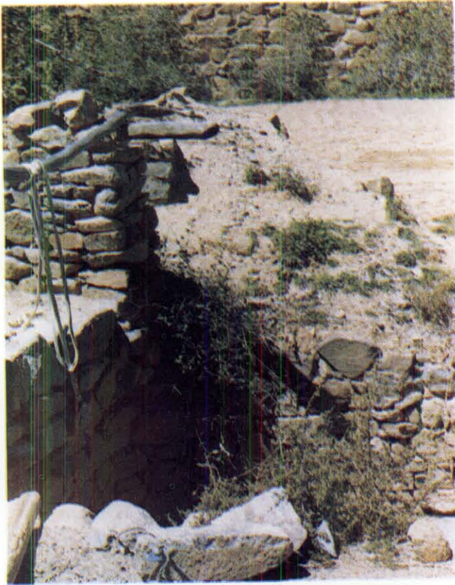
أ : سد السيلقى : جانب من اتجاه مجرى السد وبئر متصل بقناة أرضية A. Sadd as-Samallaqi; downstream side—a well with underground qanat.
